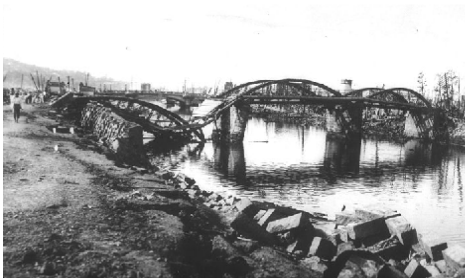
شکل ۴-۲۳- فروافتادگی عرشه پل Yoyokumi در توکیو در زلزله ۱۹۲۳ ژاپن به بزرگی ۸/۱۹ ریشتر [۶۴].
