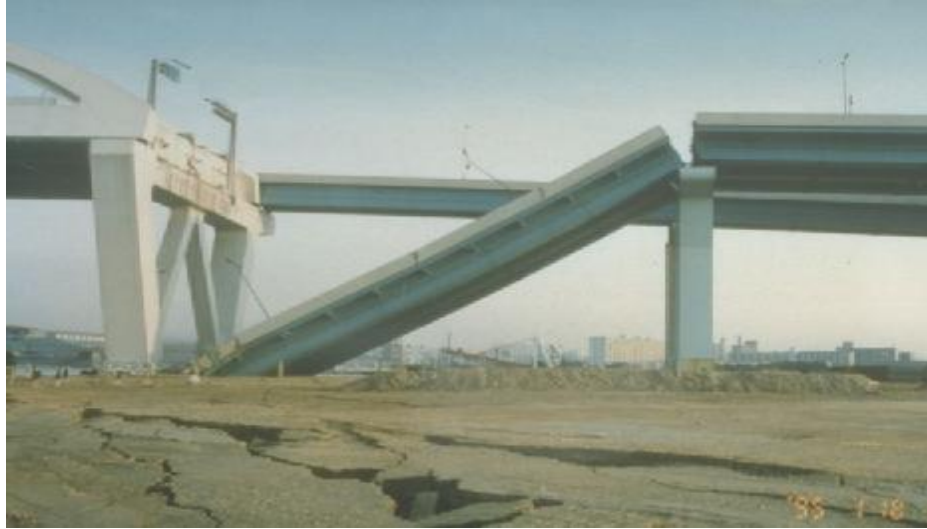
شکل ۴-۱۹- افتادگی یکی از عرشه‌های پل Nishinomiya-ko در کوبه به علت عدم کفایت نشیمن‌گاه [۶۴].
