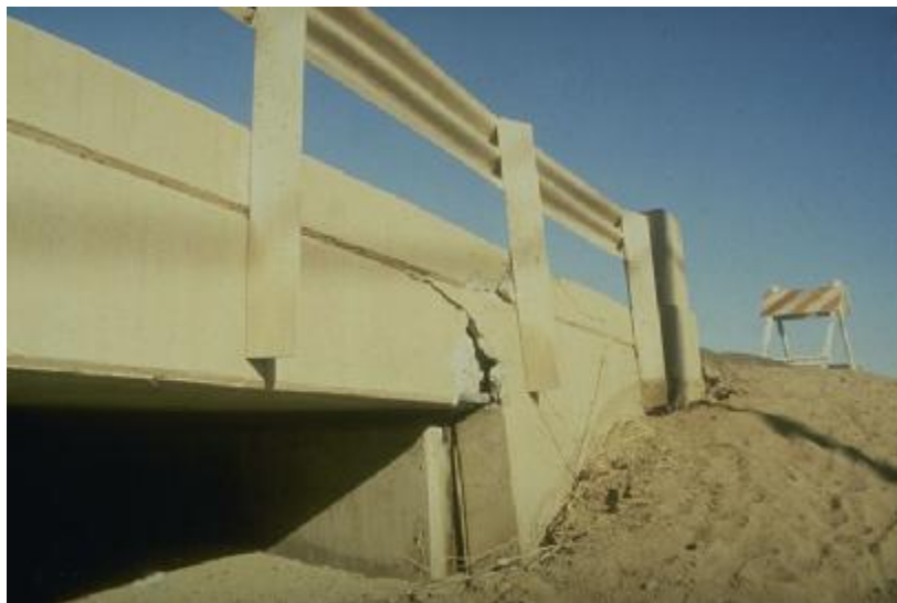
شکل ۴-۱۱۱- ایجاد تغییر شکل‌های بزرگ در کوله پل New River طی زلزله Imperial Valley در کالیفرنیا (۱۹۷۹) [۶۴].
