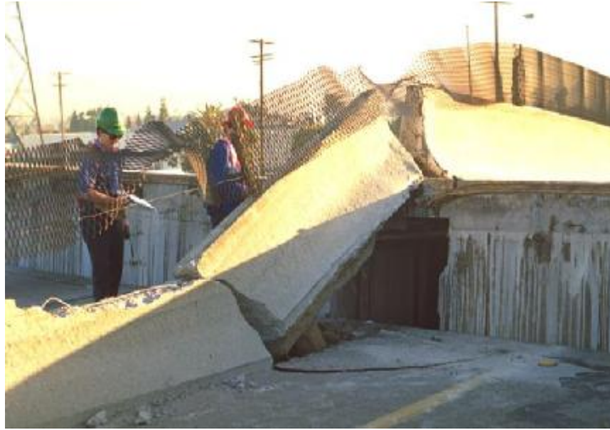
شکل ۴-۱۲- آسیب وارده به روسازه به علت بالا آمدگی کوله- Northridge [۶۴].
