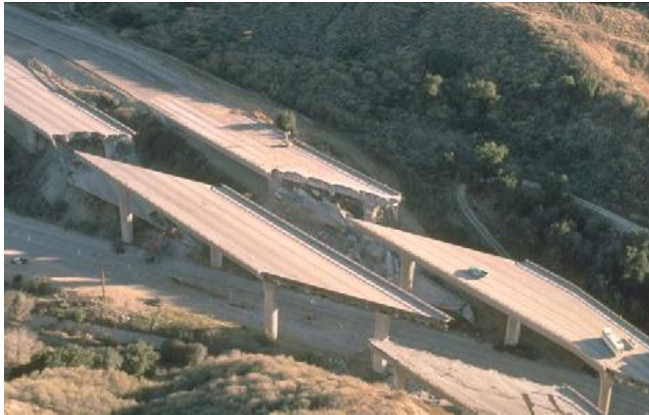
شکل ۴-۲۰- فروافتادگی روگذر مورب Gavin Canyon در زمین‌لرزه Northridge [۶۴].
