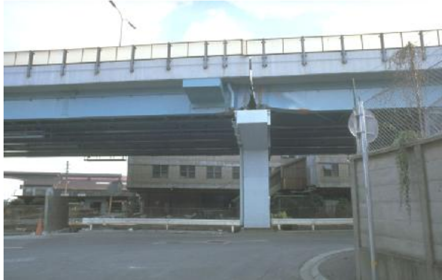
شکل ۴-۱۲۲- قطع شدن اتصال دیافراگم به شاه‌تیر فولادی قاب ۳۵۱ بزرگراه Hanshin به علت حرکت عرضی پل در زمین‌لرزه Kobe موجب وقوع کمانش در جان شاه‌تیر شده است [۶۴].
