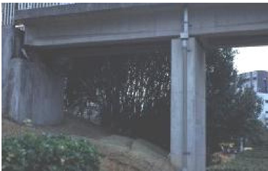
شکل ۴-۱۱۷- نشست خاک کوله (کوبه) [۵۴].
