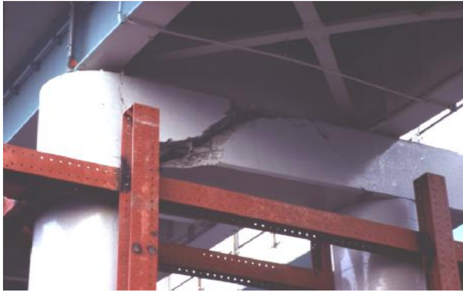
شکل ۴-۱۲۴- شکست برشی تیر سرستون در زلزله کوبه و کمانش مهاربندهای افقی [۵۴].
