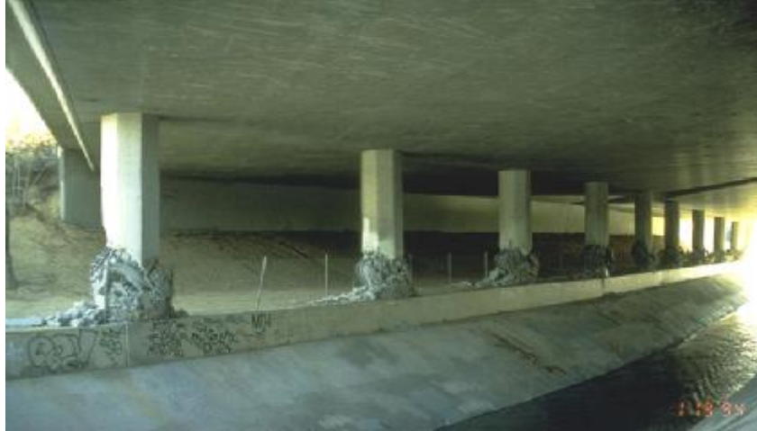
شکل ۴-۴۹- شکست ستون‌های پل عبوری از کانال Bull Creek Canyon در بالاتر از نقطه موردانتظار به علت وجود دیوار کانال در زمین‌لرزه Northridge [۶۳].
