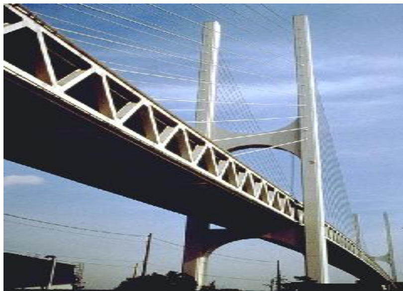
شکل ۷-۲- عملکرد مطلوب پل کابلی هیگاشی با برجهای فولادی با دو عرشه نزدیک جزیره Rokko- در پایه‌های انتهایی از تکیه‌گاه‌های پاندولی استفاده شده بود که توسط میراگر و کفشک‌های بادی کنترل می‌شدند تا به شایسته‌ها اجازه حرکت در راستای طولی داده شود (کوبه) [۵۴].
