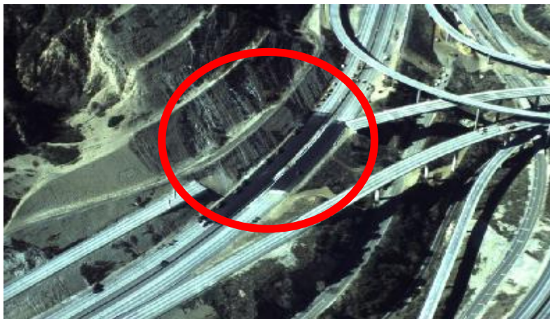
شکل ۴-۱۱۴- یکی از دلایل فروریزش قسمتی از پل آزادراه ۱۵ در نورتریج را وضعیت نامساعد خاک دانسته‌اند [۶۴].
