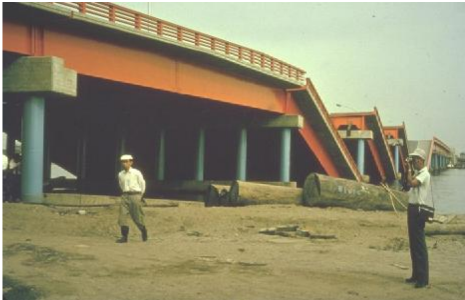
شکل ۴-۲۱- فروافتادگی عرشه‌های پل Showa در زمین‌لرزه Niigata ژاپن به بزرگی ۷/۵ ریشتر در ۱۹۶۴ [۶۴].
