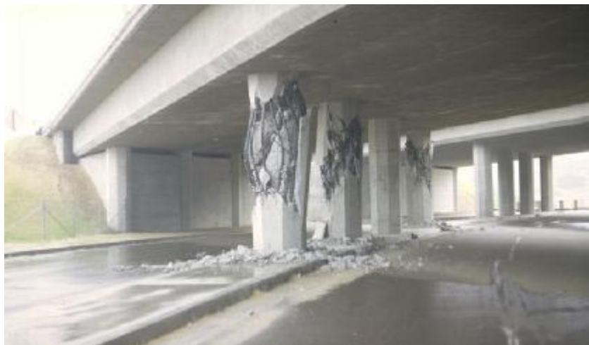
شکل ۴-۳۵- شکست ستونهای تقاطع ۵ مسیر ۲۱۰ در زمین‌لرزه San Fernando به علت ضعف مقاومت برشی پلهای ایالات متحده طرح شده قبل از ۱۹۷۱ [۶۴].
