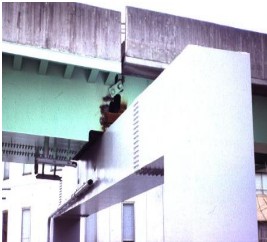
شکل ۴-۸۸- عمل مقیدکننده‌ها- این عناصر آسیب دیده‌اند (کوبه) [۵۴].
