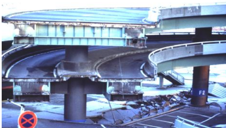
شکل ۴-۲۶- فروریزش قسمتهایی از رمپ دسترسی دو طبقه- کوبه [۵۴].
