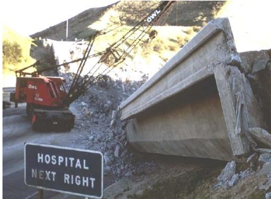
شکل پ-۷-تخریب پلی در زلزله SanFernando (۱۹۷۱) که منجر به بسته شدن مسیر یک بیمارستان هم شد [۴].
