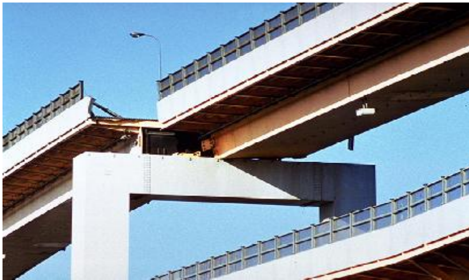
شکل ۴-۳۱- آسیب وارده به نشیمن‌گاه منجر به حرکت قابل ملاحظه عرشه در راستای عرضی شده است (کوبه) [۵۴].
