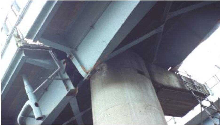
شکل ۴-۱۰- در زلزله کوبه روسازه یک پل قوس در پلان روی تکیه‌گاه‌ها لغزیده است. به کماتش بادبندها توجه کنید [۶۴].
