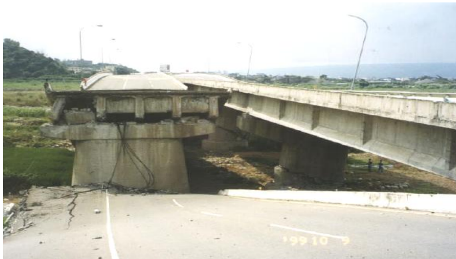
شکل ۴-۱۷- نمایش تأثیر نزدیکی به گسل و آسیب‌های شدید در پل Wu-Shi در زلزله Chi [۵۸](۱۹۹۹)Chi
