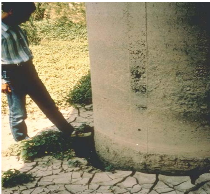
شکل ۹-۱- تغییر مکان قابل ملاحظه پایین ستون پل بالابالا در زلزله منجیل [۷۶].
