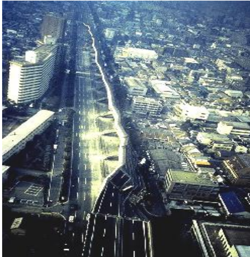
شکل پ-۱۱-انقطاع بزرگراه Hanshin و پل Higashinada پس از زلزله کوبه [۵۴].
