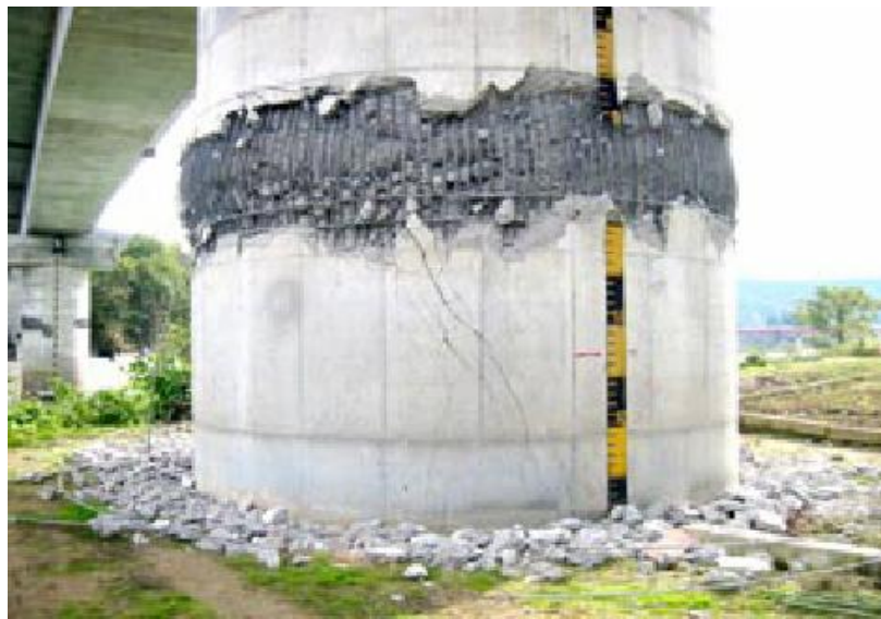
شکل ۴-۴۲- آسیب وارده به پایه بتن مسلح پل Joetsu Shinkansen Wanazu طی زلزله Niigata (۲۰۰۴) [۵۰].
