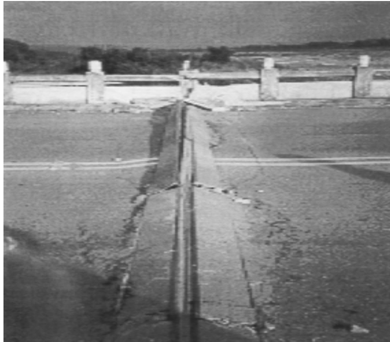
شکل ۴-۱۲۶- ایجاد ترک‌های برشی در شاه‌تیر پل Ling-Wei در نواحی تکیه‌گاهی طی زلزله Chi Chi (۱۹۹۹) [۵۸].
