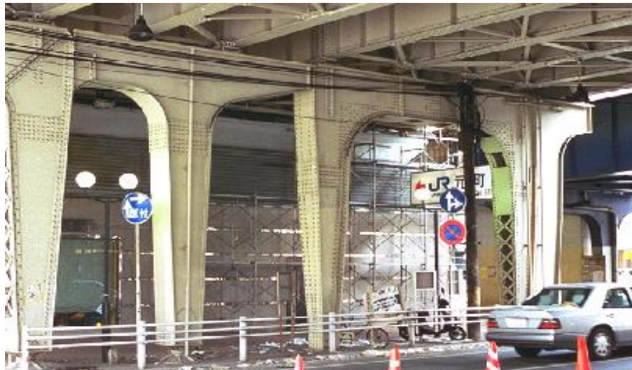
شکل ۷-۱- عملکرد مطلوب برخی از پل‌های فولادی (کوبه) [۵۴].
