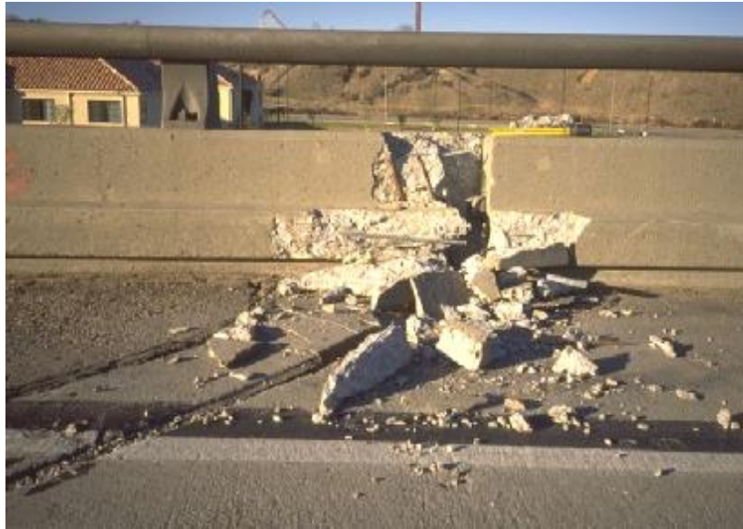
شکل ۴-۱۲۹- آسیب وارده شده به پل رودخانه Santa Clara در زلزله Northridge (۱۹۹۴) در اثر ضربه کوله به روسازه در راستای طولی [۶۴].
