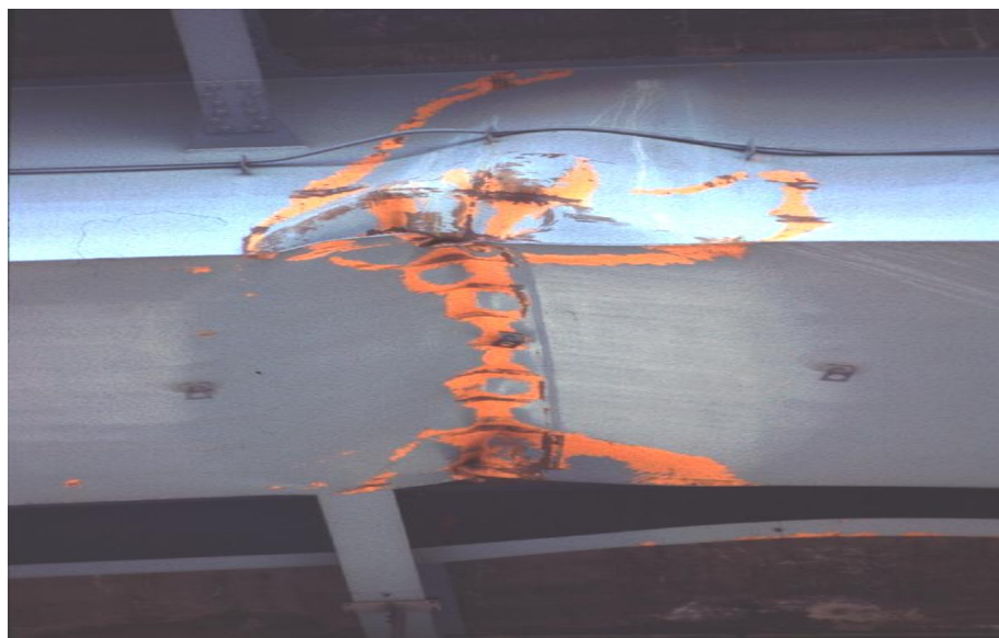
شکل ۴-۹- کماتش موضعی ایجاد شده در عناصر عرشه به علت فروریختن پایه- خطوط قرمز محل کماتش را نشان می‌دهد (کوبه) [۶۴].
