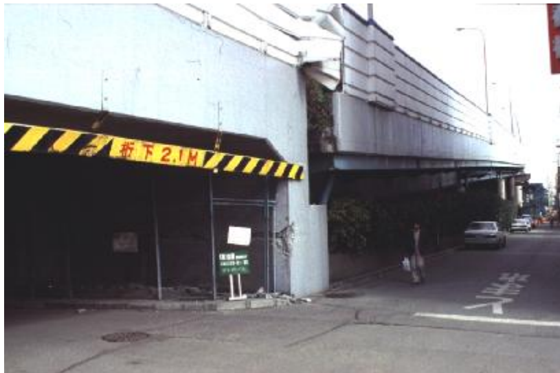
شکل ۴-۱۳۰- ضربه زدن روسازه و کوله و آسیب وارده به کوله در کوبه ژاپن- به حرکت عرضی عرشه توجه کنید [۵۴].
