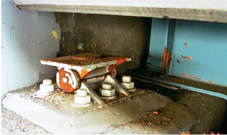
شکل ۴-۳۰- کنده شدن میل مهارهای اتصال تکیه‌گاه ثابت به شاهتیر باعث جابجایی شاهتیر شده است (کوبه) [۵۴].
