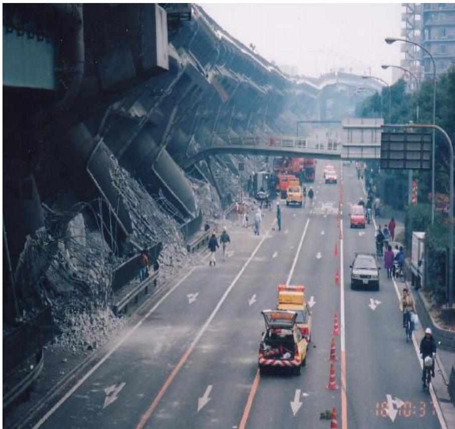
شکل ۴-۱۰۴- فروریزش تمامی ۱۷ قاب از پل Fukae از مسیر شماره ۳ بزرگراه Hanshin در زمین‌لرزه Hyogoken-Nanbu (۱۹۹۵) به علت تشدید ناشی از نزدیکی به گسل و ایجاد تغییرشکل‌های بزرگ [۵۴].
