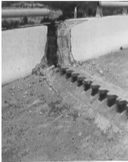
شکل ۴-۱۲۵- الف و ب - آسیب وارده به درز انبساط پل Chang-Geng در زلزله Chi Chi (۱۹۹۹) [۵۸].
