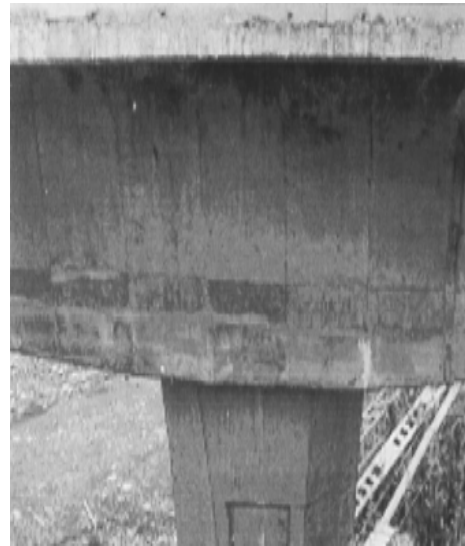
شکل ۴-۱۲۵- الف و ب - آسیب وارده به درز انبساط پل Chang-Geng در زلزله Chi Chi (۱۹۹۹) [۵۸].
