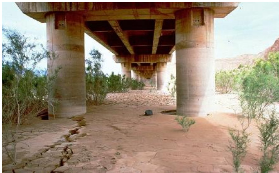
شکل ۹-۲- عملکرد نسبتاً خوب پل بالابالا در زلزله منجیل - به پدیده جوشش ماسه توجه شود [۷۹].
