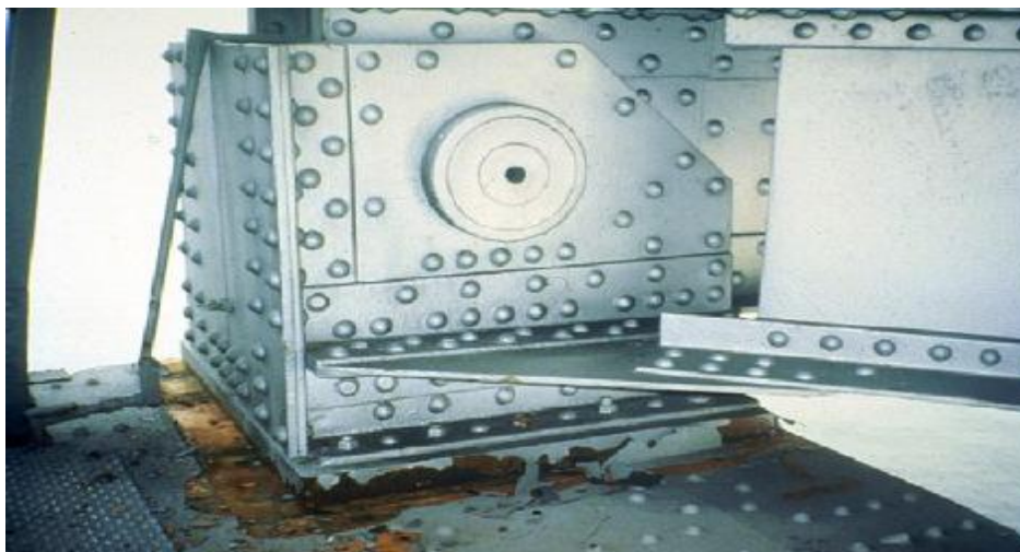
شکل ۴-۳۲- آسیب وارده به نشیمن‌گاه در راستای عرضی در Bay Bridge در زلزله Prieta Loma (۱۹۸۹) [۵۲].
