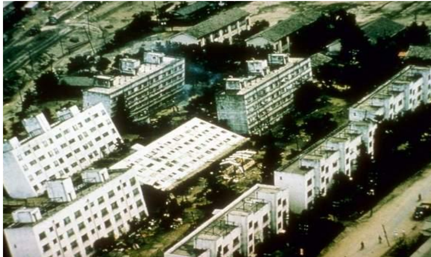
شکل پ-۶- فروریزش کامل چند مجتمع مسکونی به علت پدیده روانگرایی خاک در زلزله
