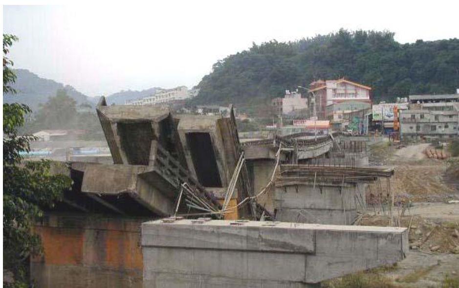
شکل ۴-۱۸- نمایش تأثیر نزدیکی به گسل و آسیب‌های شدید در پل عبوری از رودخانه Tachia در زلزله Chi Chi [۵۸](۱۹۹۹)Chi
