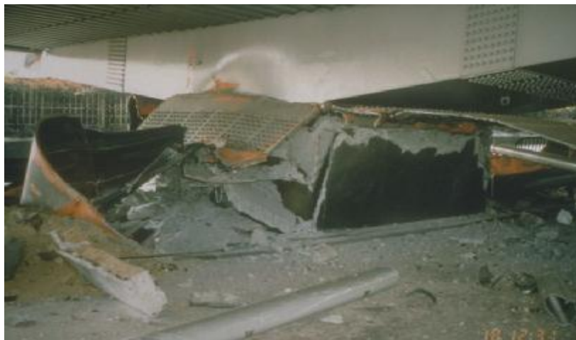
شکل ۴-۶۷- نمای نزدیک از ستون فروریخته - کوبه [۶۴].
