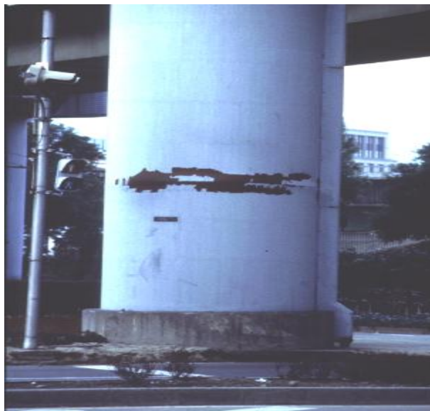
شکل ۴-۷۱- کمانش پافیلی در میانه پایه جدارنازک مدور فولادی [۵۴].
