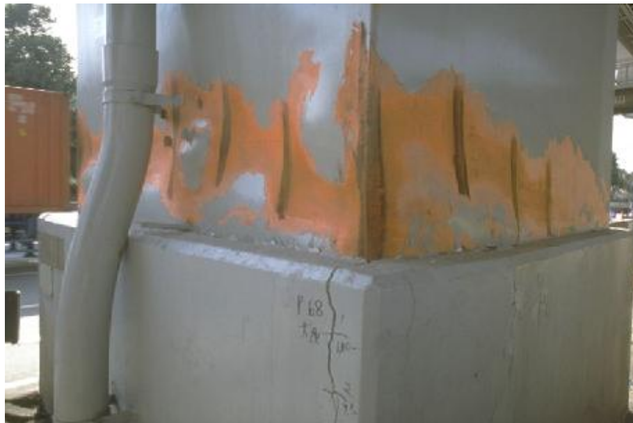
شکل ۴-۷۰- کمانش موضعی یک ستون دارای سخت‌کننده- کوبه [۷۴].
