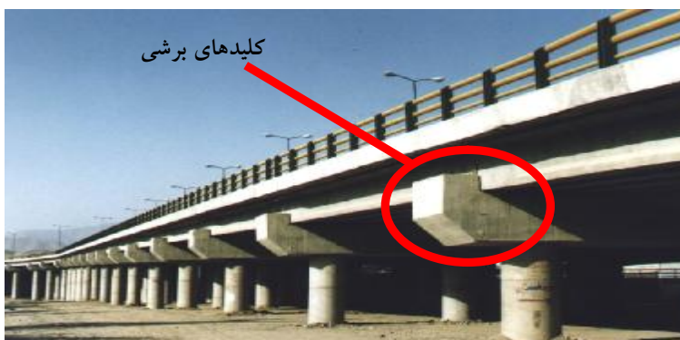
شکل ۴-۹۳- نمایش کلیدهای برشی خارجی در یکی از پل‌های کشور به جهت مقید نمودن حرکت‌های عرضی عرشه
