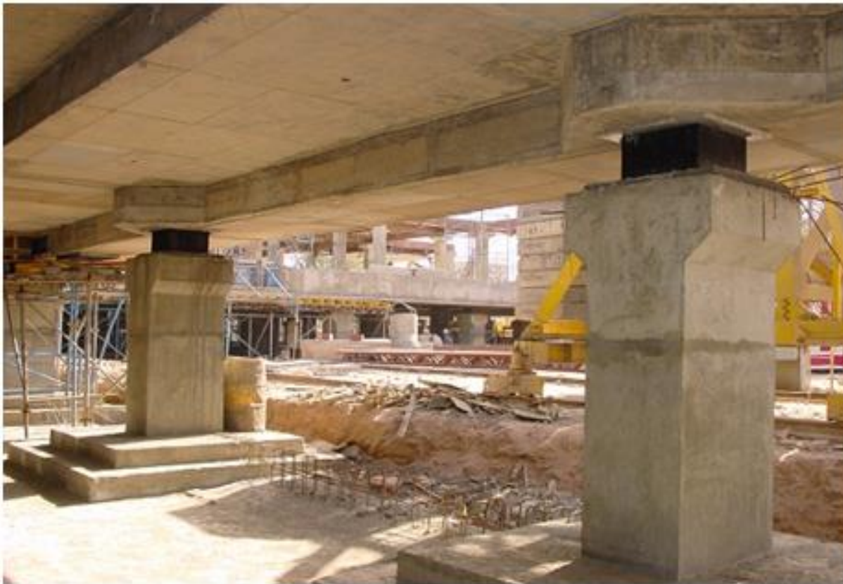
تصویر ۱۰: اجرای LRB
