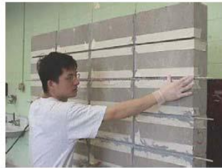
(d) Installation of GFRP Rods
